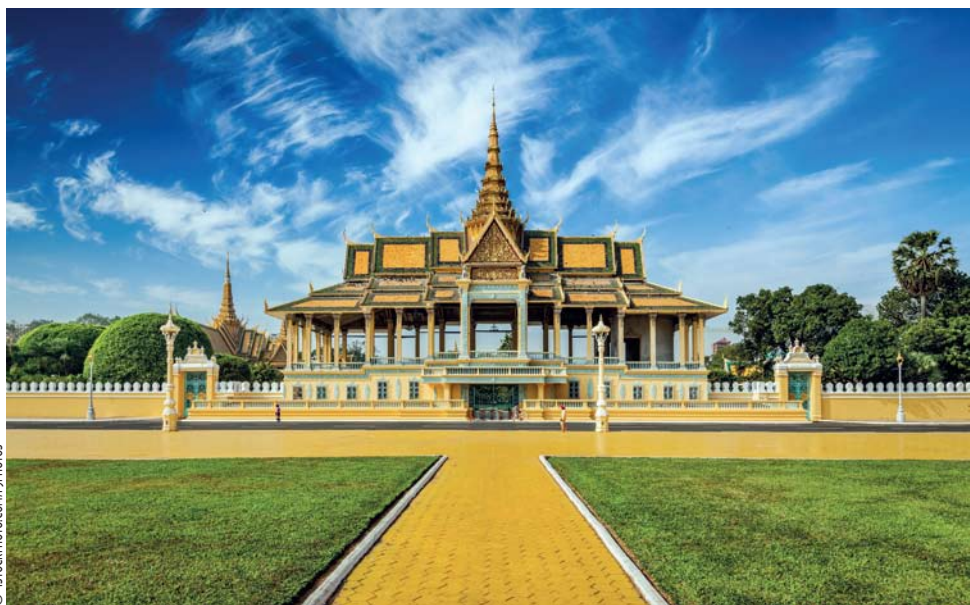
▼ Budowa Pałacu Królewskiego w stolicy Kambodży rozpoczęła się w 1866 r. z rozkazu króla Norodoma (1834–1904)
