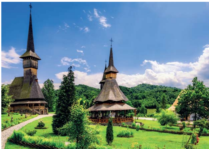
▲ Cerkiew Wprowadzenia Matki Bożej do Świątyni, drewniana budowla z 1720 r., stojąca na wzgórzu za Bărsaną
