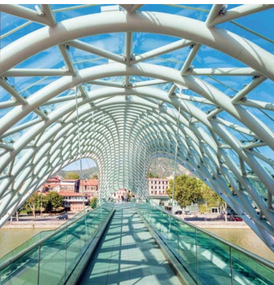
▲ Most Pokoju, kładka dla pieszych nad rzeką Kurą
