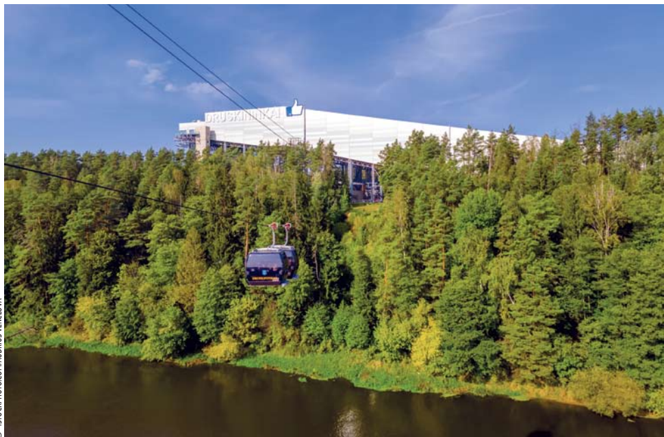
▲ Snow Arena – jedyny catoroczny kompleks sportów zimowych w krajach bałtyckich – i nowoczesna kolej linowa
