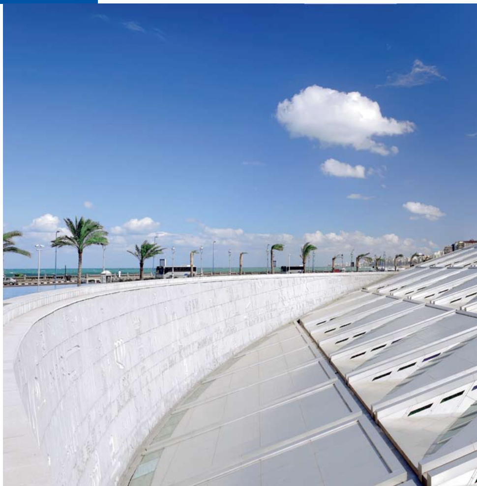
▲ Nad główną czytelnią znajduje się szklano-aluminiowy dach o wysokości 32 m i średnicy ok. 160 m
