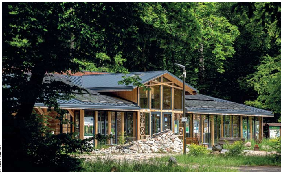
▲ Budynek Centrum Turystyki i Promocji „Krainy Żubra” w Budach Leśnych przy drodze do Białowieży
