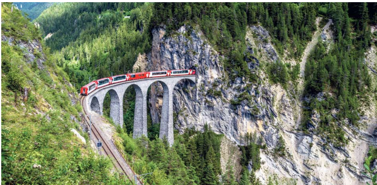
▲ Wiadukt Landwasser zbudowano w latach 1901–1902 z miejscowego, ciosanego kamienia wapiennego
