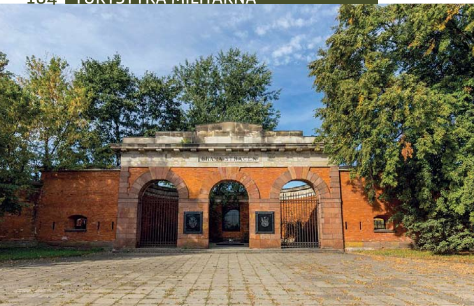
▲ Cytadelę Warszawską zbudowano w latach 1832–1834
