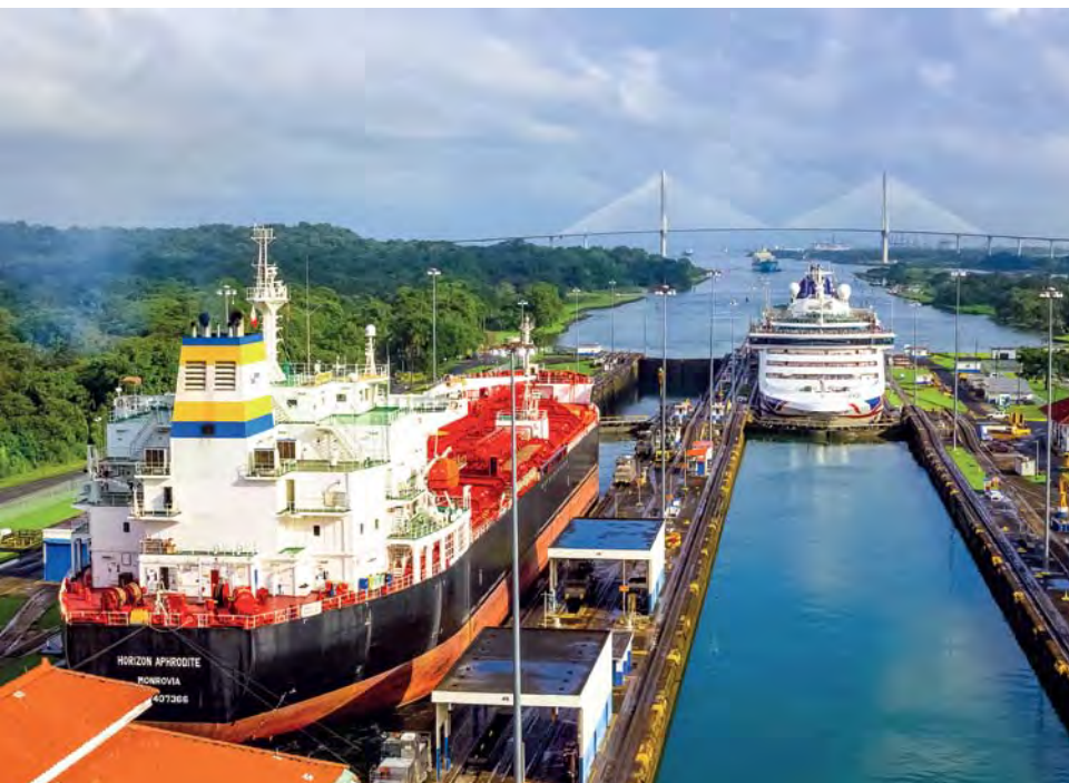
▲ Śluzę podnoszą statki o 25,9 m do najwyższego punktu Kanału Panamskiego – jeziora Gatún, a potem je opuszczają
