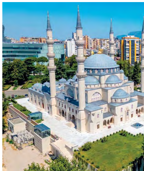
▲ Otwarty w październiku 2024 r. tirański Wielki Meczet
